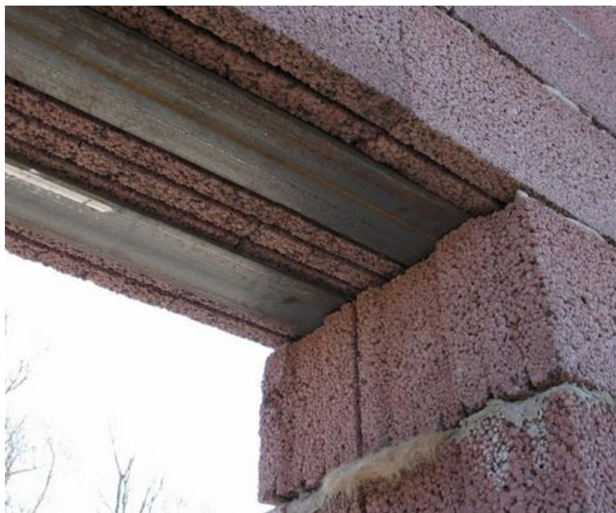
Фото: общий вид металлической перемычки.
