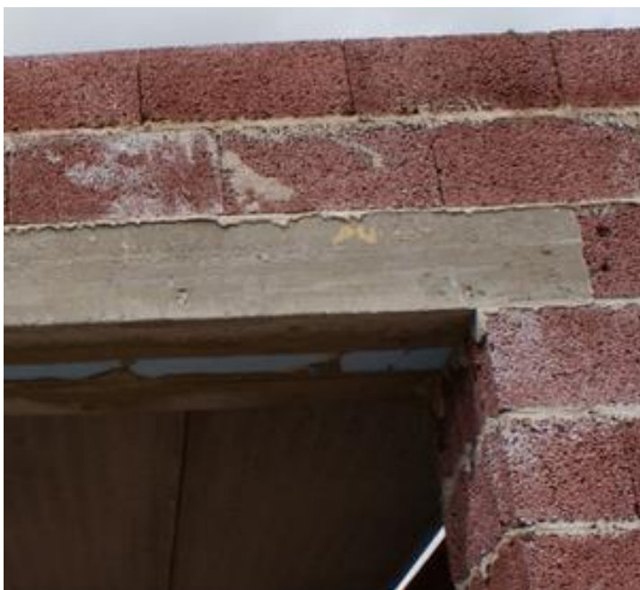
Фото: общий вид бетонной перемычки с полистирольной вставкой.
